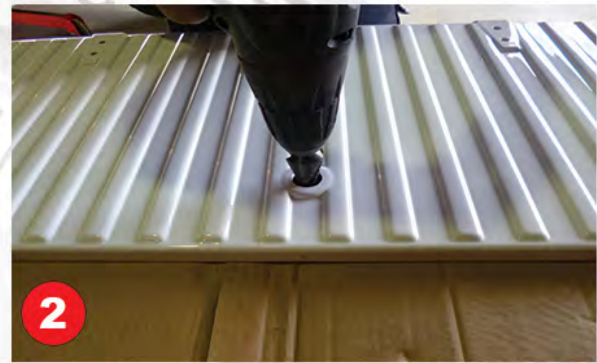
2 Perçage de la poignée de serrure Fraise ou foret
