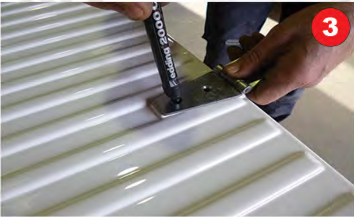
3 Traçage du perçage des Charnières
