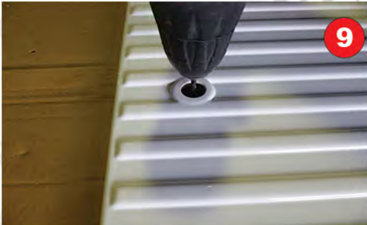
9 Perçage de part en part avec un foret diamètre 5 mm au centre
